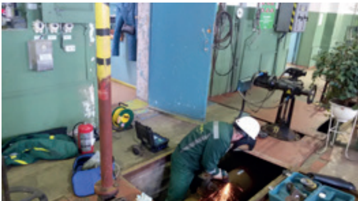
Специалист отдела энергоконсалтинга готовит точку замеров на насосной станции
