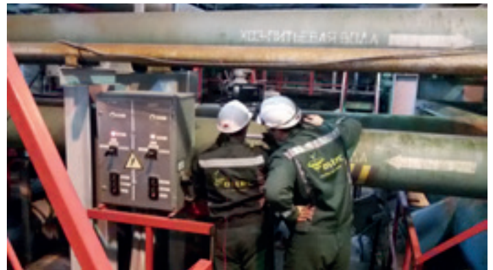
Специалисты отдела энергоконсалтинга устанавливают переносной расходомер на трубопровод ХПВ на ВОС
